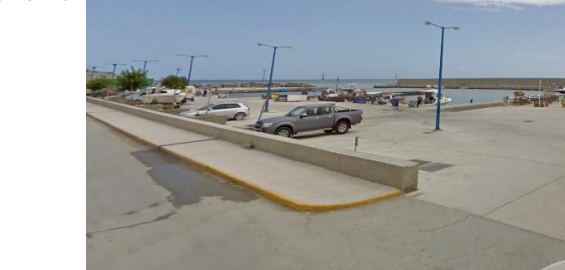
ΣΧΟΛΙΑ/ΠΑΡΑΤΗΡΗΣΕΙΣ: Τοποθέτηση επί των οριοθετημένων θέσεων στάθμευσης
